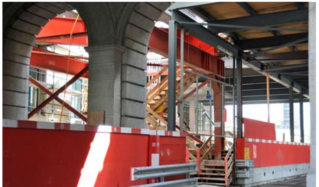
Zwischen imposanten Stahlträgern eine Holzterre: Eingangsbereich Clausiusstrasse während der Umbauzeit.
